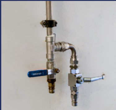
LLAVE DOBLE SOBRE TUBERÍA RÍGIDA
