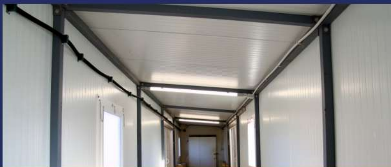
LINEA DE ALTA PRESIÓN CON LATIGUILLOS
