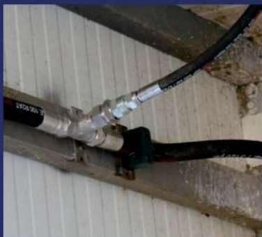
CONEXIÓN CON DERIVACIONES 100 - 120 L/M
